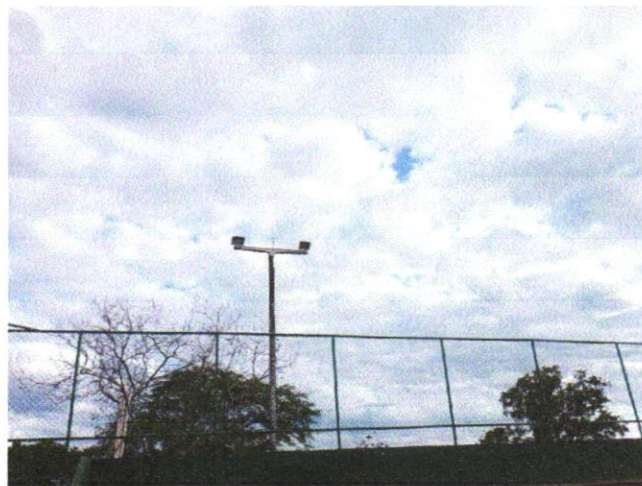
FOTO 01 - ALAMBRADO PARA QUADRA POLIESPORTIVA, ESTRUTURADO POR TUBOS DE AÇO GALVANIZADO, (MONTANTES COM DIÂMETRO 2", TRAVESSAS E ESCORAS COM DIÂMETRO 1 1/4"), COM TELA DE ARAME GALVANIZADO, FIO 10 BWG E MALHA
